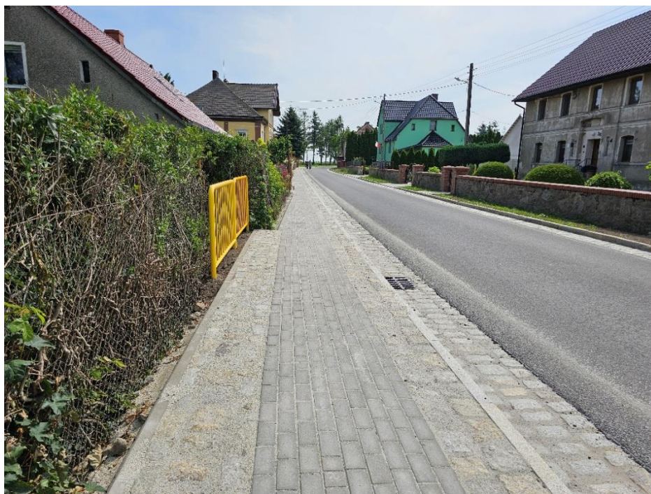
Fot. IX.1. Droga powiatowa nr 2797D relacji Budziszów Mały – Budziszów Wielki
