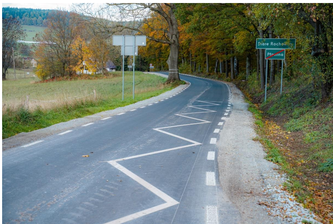
Fot. IX.3. Droga powiatowa nr 2830D relacji Stare Rochowice – Płonina
