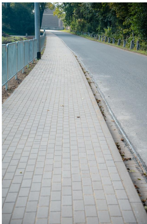
Fot. IX.7. Droga powiatowa nr 2176D relacji Jawor - Godziszowa
