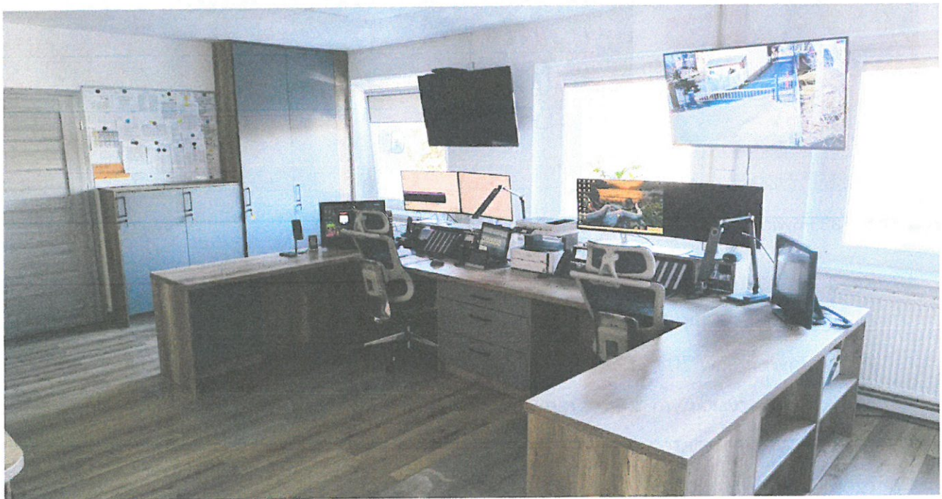
Rysunek 35 Widok na Stanowisko Kierowania po remoncie
