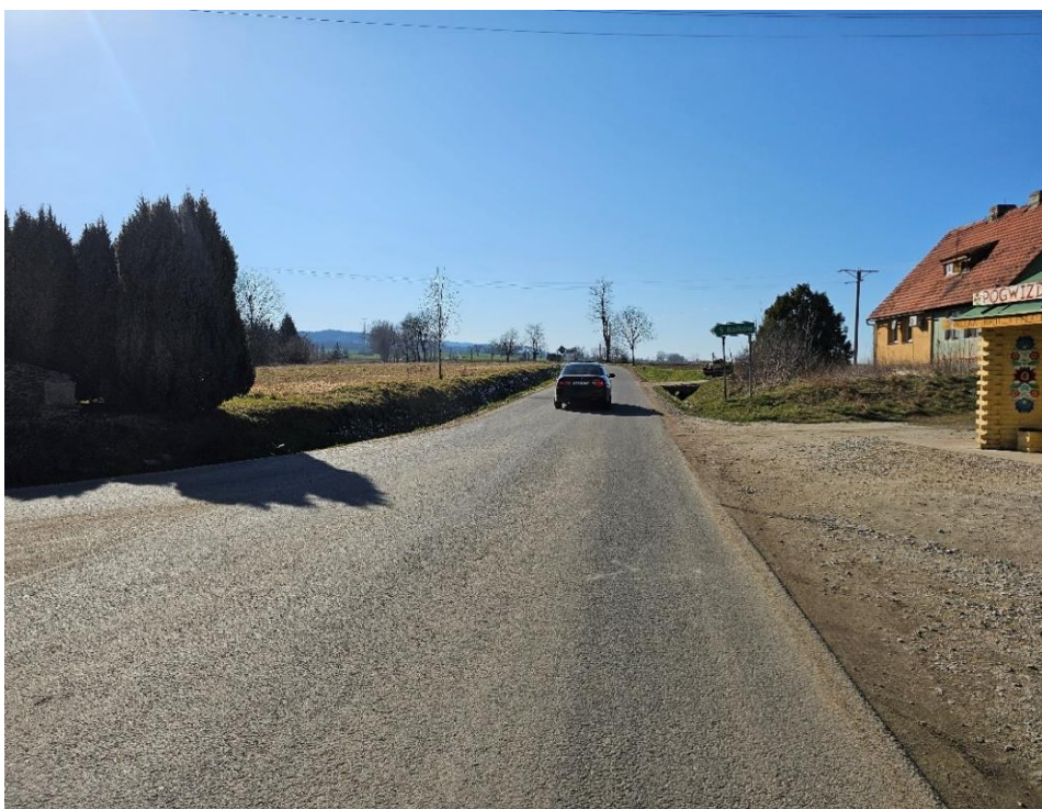
Fot. IX.1.3. Droga powiatowa nr 2815D w Pogwizdowie
