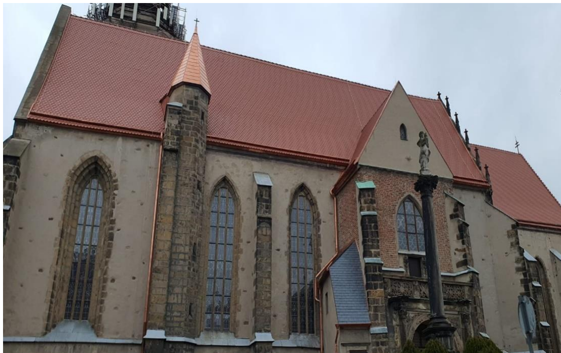
Fot. IX.1.23.: Pokrycie dachowe w Kościele św. Marcina w Jaworze
