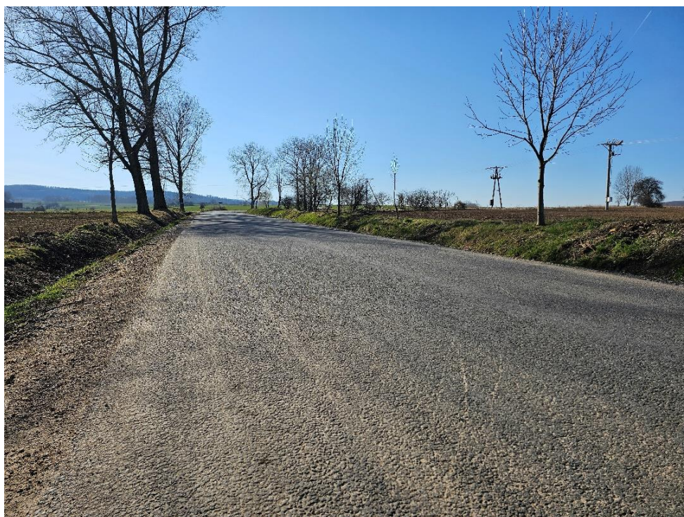
Fot. IX.1.5. Droga powiatowa nr 2815D relacji Lipa - Jastrowiec - Pogwizdów
