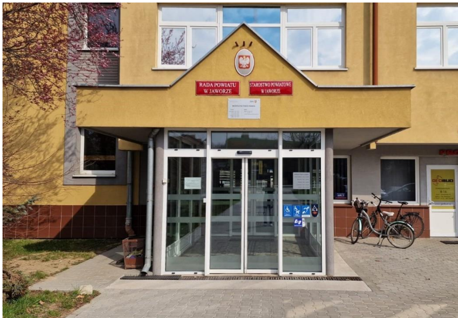
Fot. IX.1.19-20.: Drzwi automatyczne w Starostwie Powiatowym w Jaworze
