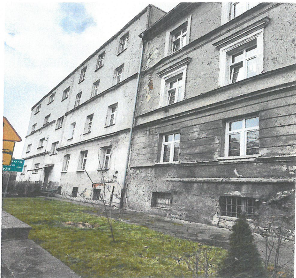
Elewacja budynku od ul. Starojaworskiej przed remontem.
