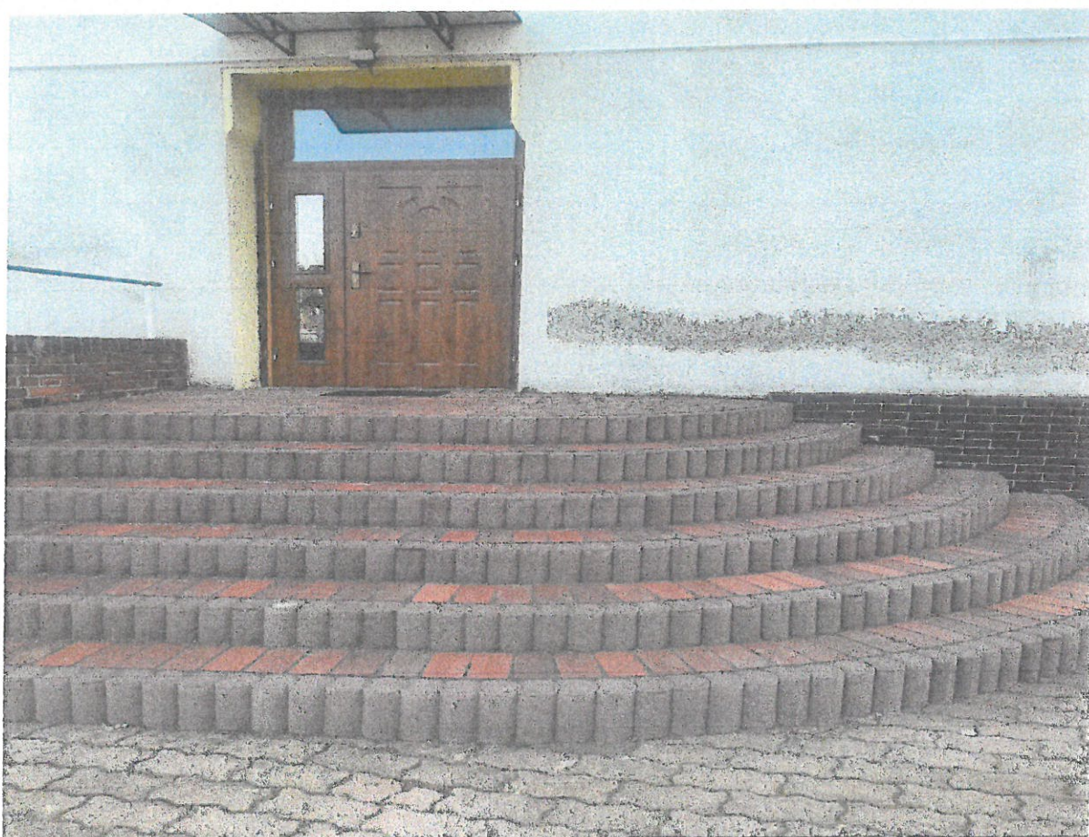
Wyremontowane schody zewnętrzne wraz z nowymi drzwiami.
