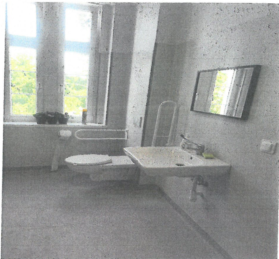
Łazienka bez barrier architektonicznych.
