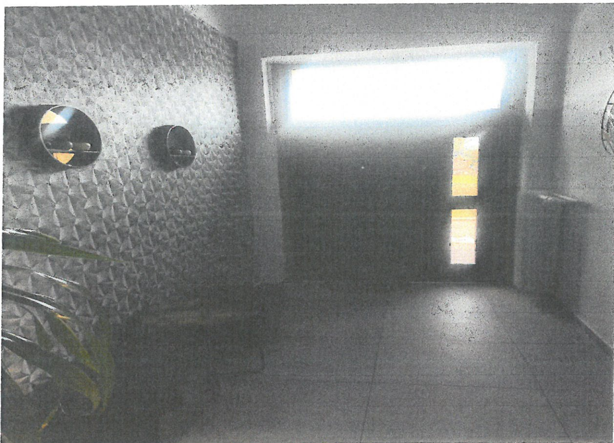
Wyremontowana część korytarza.
