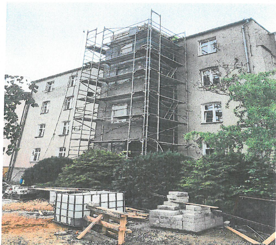
Budowa windy zewnętrznej.
