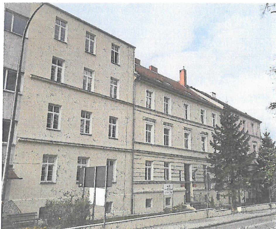
Elewacja budynku od ul. Starojaworskiej po remoncie
